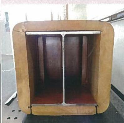
写真5 内部にH鋼が入っている行桁の断面
